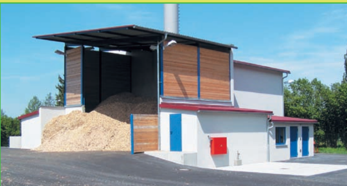
Der Schubboden des Biomasse-Heizwerkes ist mit Holz hackschnitzeln gefüllt.
